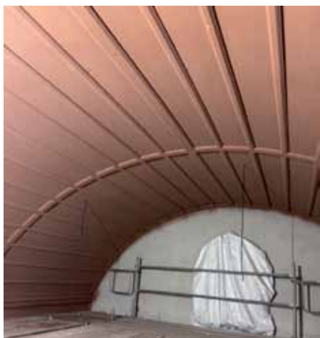
Das gereinigte Tonnengewölbe
